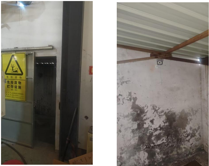
危险废物仓库
