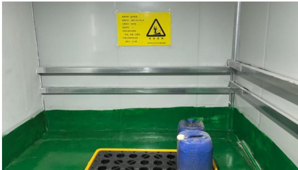
危险废物仓库
