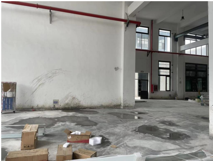
附图 6-2 本项目生产车间现状照片
