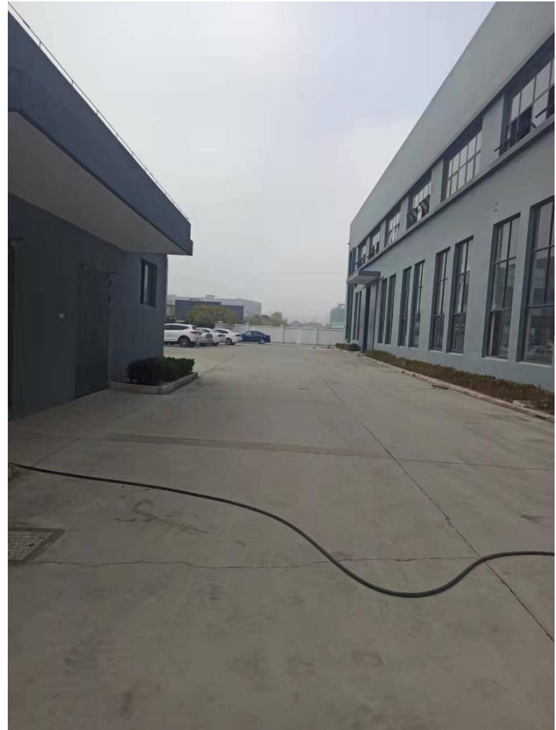
附图 5-2 本项目厂房外部现状照片
